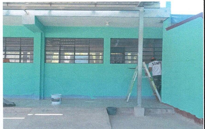
Foto 4: En pleno proceso de pintado de muros
