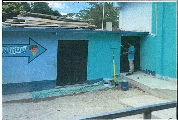
Foto 2: En pleno proceso de pintado de muros
